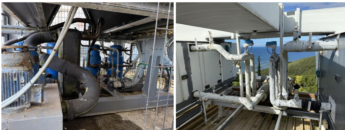
Figure 21 – Photo groupe d'eau glacée et réseau
